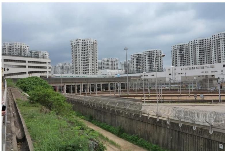
Рис. 2.16 Застройка района Хенг Фа Чуен (*Heng Fa Chuen*) на перекрытии депо метрополитена «*Chai Wan Depot*»
