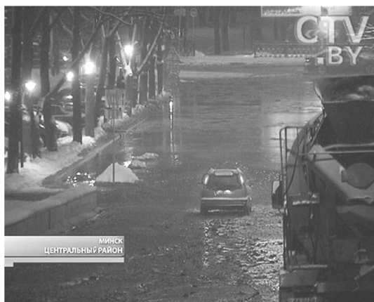
Рисунок 2.2. Последствия аварии 30.12.2009 из-за ошибочной информации в кадастре подземных сооружений г. Минска, ул. Интернациональная
