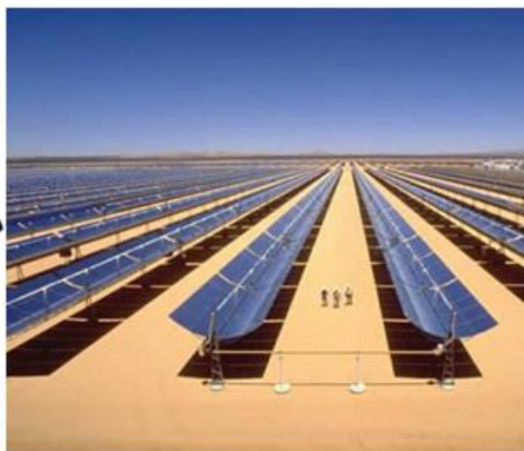
Рисунок 9.2.3.15. Параболо-цилиндрические концентраторы.
