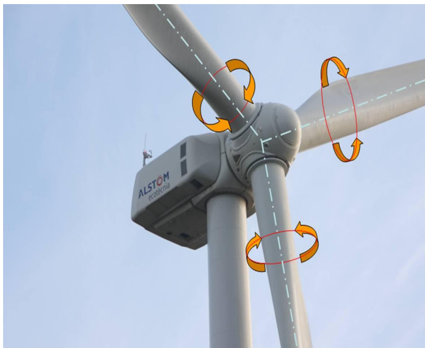
Рисунок 9.3.3.14. Pitch-регулирование ВЭУ
